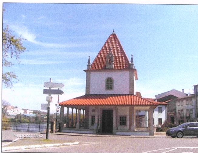
Reabilitação da capela na Sra da Ponte, em Barcelinhos
