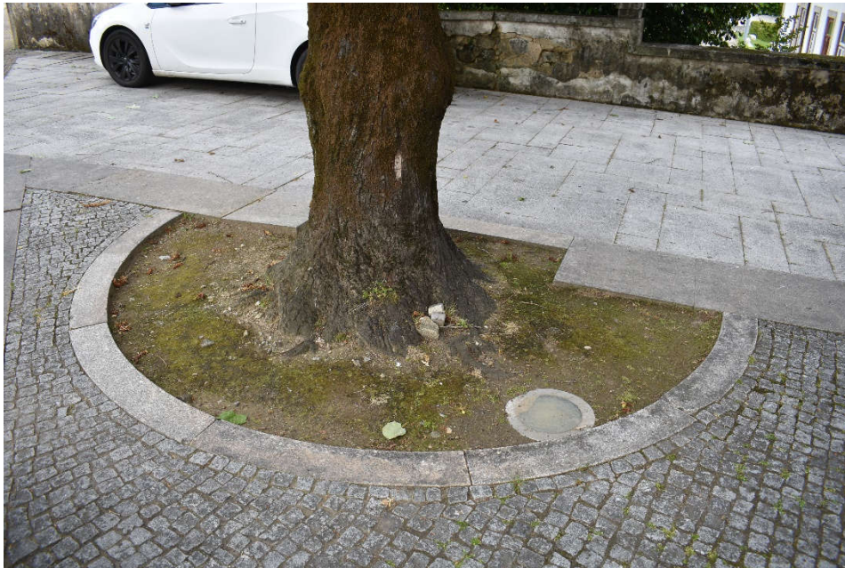
Figura 2.1 – Tília (7.01) onde houve corte de raízes para instalar lancis e sistemas de iluminação.
