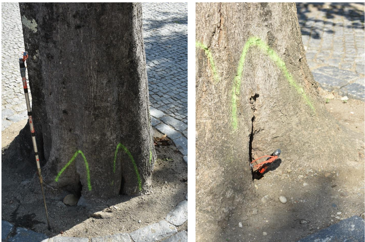
Figura 3.3 – Sonda de um metro de comprimento, completamente enterrada no colo da árvore com 1.010.
