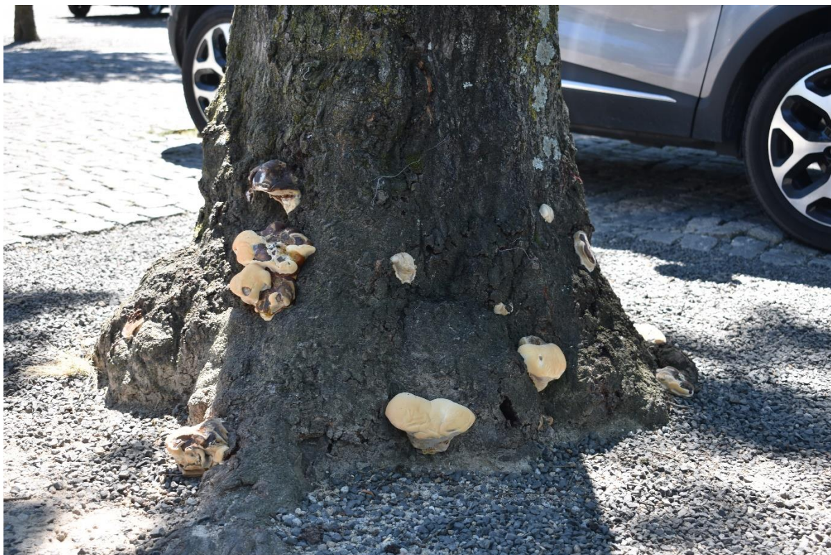
Figura 4.9 – Árvore 4 055 com cavidade no tronco muito afetada por fungos no colo, tronco e raiz.
