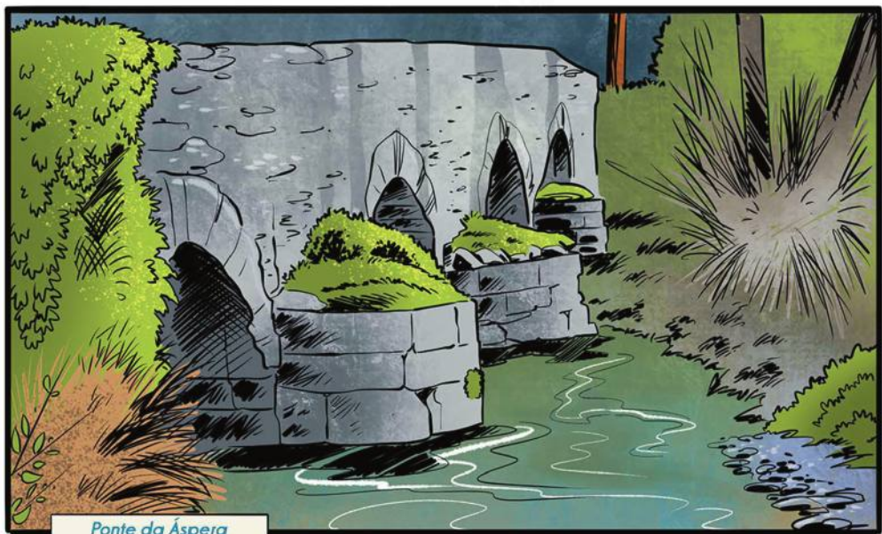
Ponte da Áspera
