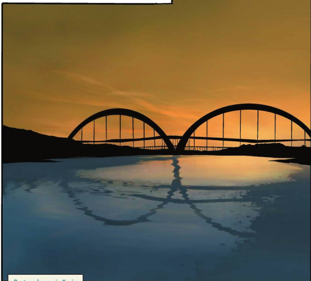
Ponte sobre o rio Xuvia
