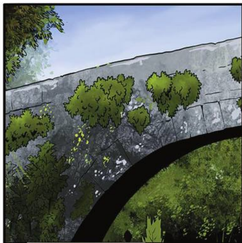
Ponte Pedrinha (Goães)
