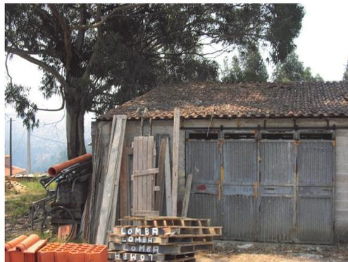
Figura 13 — Acumulação de material combustível junto à edificação.
